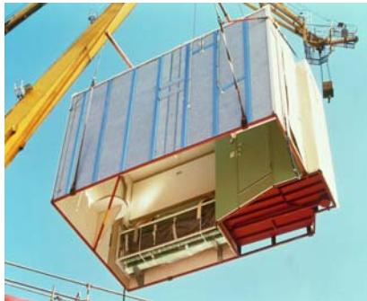
Звуковая защита и пожарная безопасность модульных кают обеспечивается благодаря жесткой изоляции из базальтовой ваты.
